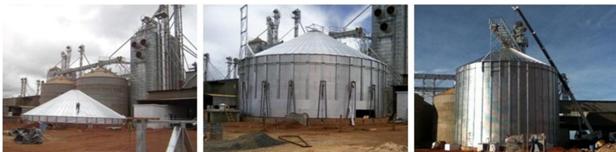
FIGURA 1. Silos metálicos elevados.
