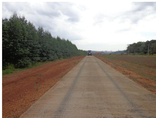
Figura 1 - Vista da pista de concreto.
