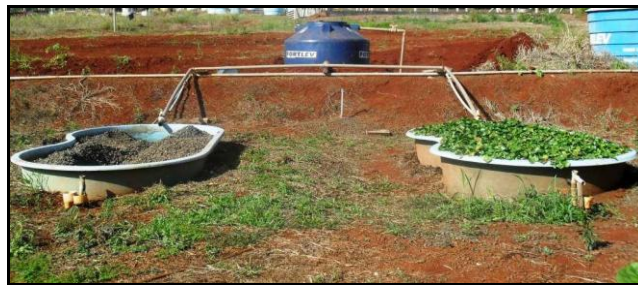
FIGURA 1. Caixa de armazenamento, leito controle com brita e leito cultivado com aguapé.
