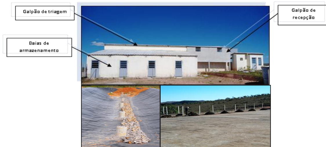
FIGURA 01: Galpão de Recepção, galpão de triagem e baias de armazenamento, vala do aterro sanitário e área da compostagem.
