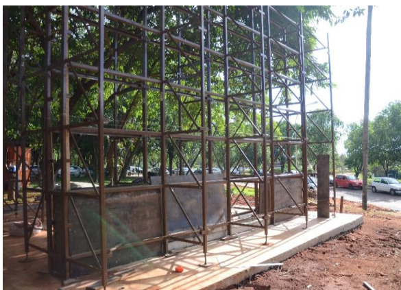
FIGURA 1. Fôrma – estrutura treliça.
