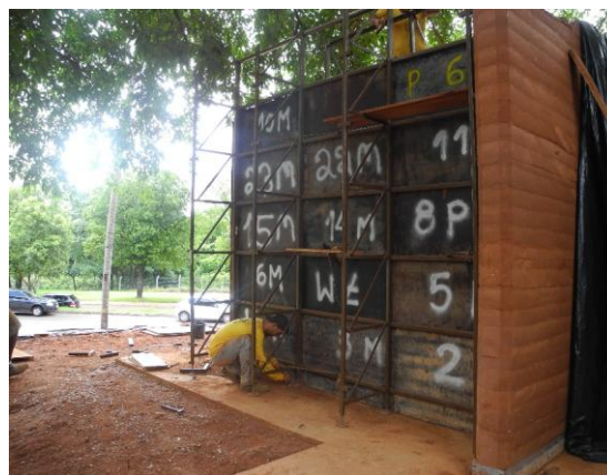
FIGURA 2. Fôrma - fechamento madeirite.
