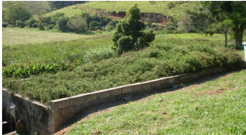
Figuras 02 - Wetland construído vegetado com mini papiro da ETE da UEP animais de grande porte - bovinocultura leite do IFSULDEMINAS Campus Inconfidentes.
